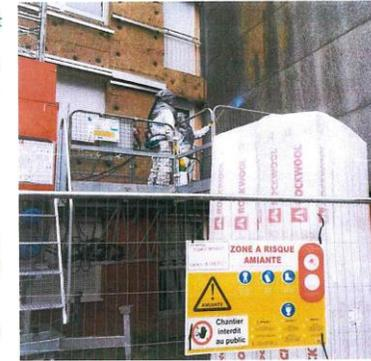
Photo : Exemple de condition d'intervention amiante
